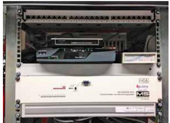
Übertragungsgerät für Testauslösungen
