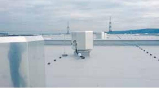
**Industriehallen: Dachventilatoren für die bedarfsgerechte Belüftung. Lichtkuppeln sollen für die natürliche Entrauchung sorgen – die bei Windlasten jedoch nicht sichergestellt werden kann.**
