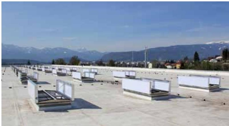
Doppelklappen Typ „Phönix“, die auch zur Lüftung mit einem Öffnungswinkel von 90° geöffnet werden.
