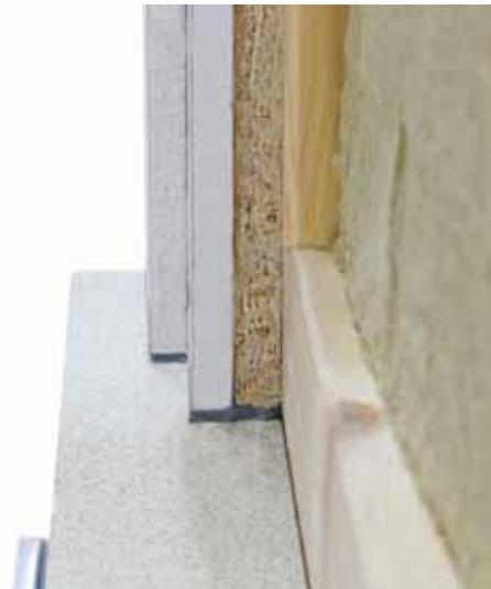
**Speziell hierauf geprüfte Brandschutzklappen können in Holzrahmenwänden verbaut werden, ohne die Laibung in der Einbauöffnung mit Gipsplatten verkleiden zu müssen.**
