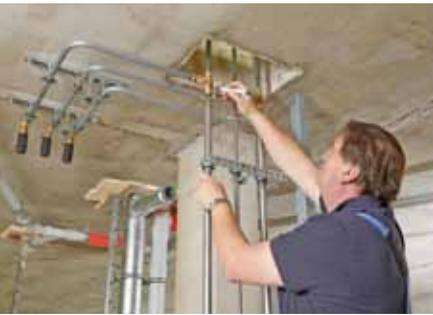
Das allgemein bauaufsichtliche Prüfzeugnis für Viega Brandschutzlösungen erlaubt praxisgerecht die Verfüllung von Restöffnungen bis zu einem Restspaltmaß von  $\leq 170$  mm. Diese Lösung ist damit abnahmesicher, ohne die Decke aufwändig wiederherzustellen zu müssen.
