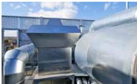
**Die Installation von Dual-Use Brandgasventilatoren können eine sichere Entrauchung gewährleisten und für den Luftaustausch in der Halle sorgen.**
