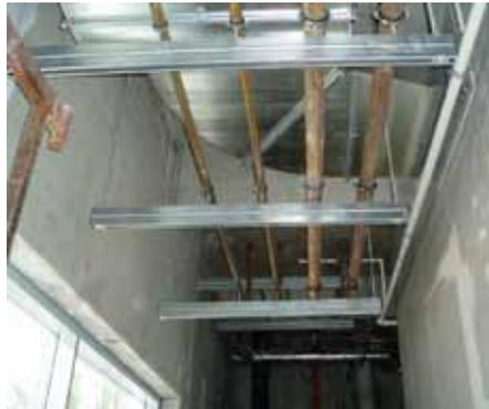
Werden Rohrleitungen in Brandschutzbereichen verlegt, muss die Befestigungstechnik brandschutztechnisch geprüft und ausgelegt sein.
