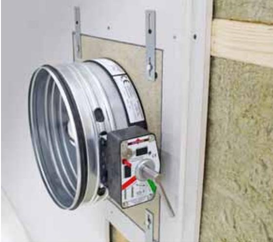
Nicht alle Brandschutzklappen sind für sämtliche Wandstärken geeignet. Besonders umfangreich einsetzbar sind Produkte mit einem werkseitig vormontierten Einbaurahmen (im Bild: Rückseite einer Brandschutzklappe mit Einbaurahmen in Holztafelwand).
