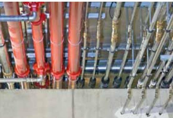
**In schätzungsweise 80% der Anwendungen werden Leitungen durch rechteckige Durchbrüche geführt. Denn Kernbohrungen erhöhen den Aufwand und werden dann eher zur Wanddurchführung einzelner Leitungen genutzt.**
