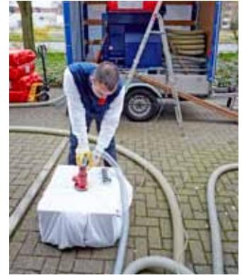
Der korrekte Einblasdruck wird vorab überprüft, um eine homogene Verfüllung mit einer Rohdichte von 100 bis 120 kg/m<sup>3</sup> zu gewährleisten.
