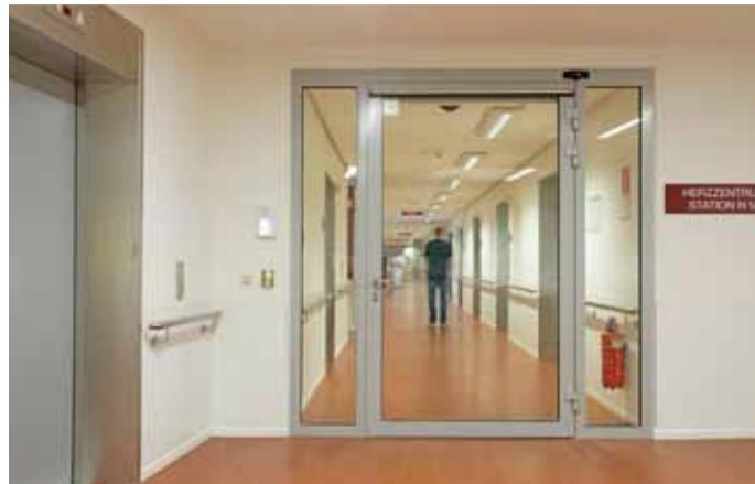
Bei Türausführungen mit Drehflügelantrieben sind drei Türbänder vorgeschrieben, im Standard reichen zwei bis zur Türhöhe von 2,5 m aus.
