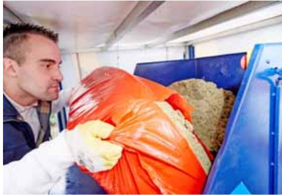
Die Einblasmachine wird mit „Conlit Firesafe“-Granulat befüllt. Sie befördert dieses mit Luftdruck zu den Verfüllungsöffnungen auf allen Etagen.
