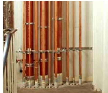
In der Praxis aufgrund des Platzbedarfs immer seltener zu finden: Durchführungen, bei denen die Abstandsregelungen über Kernbohrungen gewährleistet sind.
