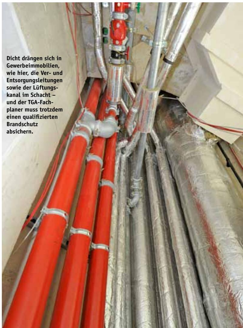
Dicht drängen sich in Gewerbeimmobilien, wie hier, die Ver- und Entsorgungsleitungen sowie der Lüftungskanal im Schacht – und der TGA-Fachplaner muss trotzdem einen qualifizierten Brandschutz absichern.
