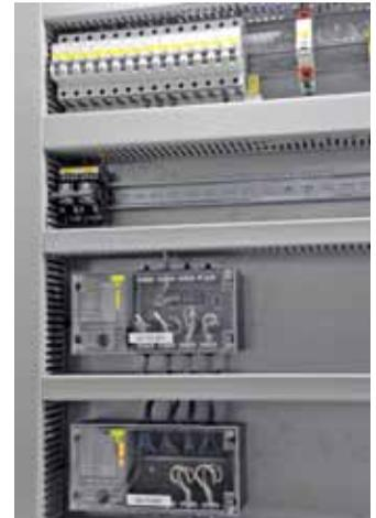
Neben dem I/O-Modul (unten im Bild) befindet sich auch der Subnetzcontroller (Bildmitte) für die Verwaltung der vier nachgeordneten Netze in dem Schaltschrank.
