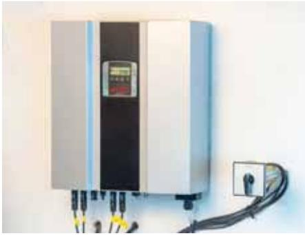
Abb. 2: Einfache nachträgliche Installation zum Kurzschluss von PV-Modulen und -Strings: Der Paketschalter (im Bild mit demontiertem Gehäuse) wird DC-seitig vor dem Wechselrichter platziert.
