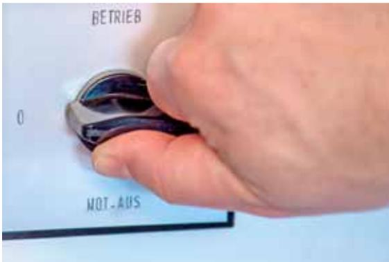
Abb. 4: In der „0-Position“ ist die Verbindung von den PV-Modulen zum Wechselrichter unterbrochen. Mit der Schalterstellung „Not-Aus“ sind die Module kurzgeschlossen. So sind von dieser strategisch günstigen Stelle aus alle DC-Leitungen mit einem Handgriff spannungslos geschaltet.
