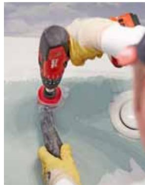
Zur Untersuchung des Schachtes und seiner Belegung wird zuerst eine kleine Öffnung in die Schachtwand gebohrt, durch die dann eine Endoskopkamera in den Schacht gelassen werden kann.
