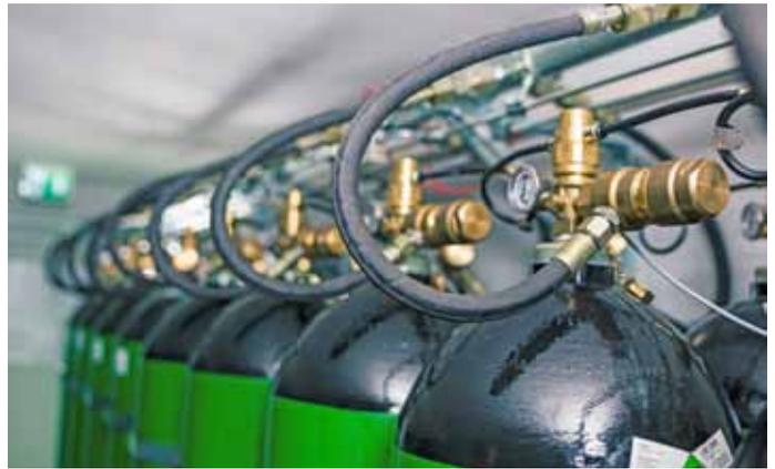
Durchflussregler an den Löschmittelflaschen minimieren Druckspitzen zu Beginn des Löschvorgangs.
