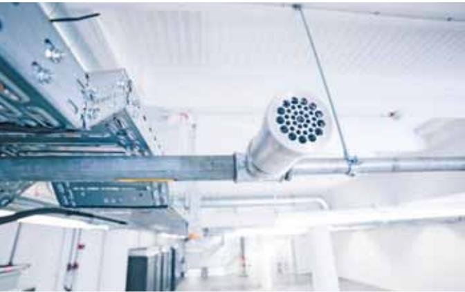
Speziell entwickelte Schalldämpfer an den Löschdüsen sorgen für Sicherheit.
