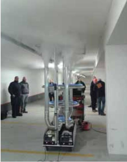
Durch ein interdisziplinäres Montageteam aus Steuerungs- und Strömungstechnikern lassen sich die Anpassungen an die aerodynamischen Verhältnisse im Gebäude durch Rauchgastests vornehmen.
