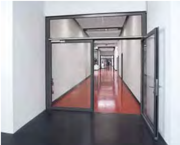
Zweiflügelige Stahlrohrrahmentür mit Oberlicht und Feststellvorrichtung für einen ungehinderten Personenfluss.
