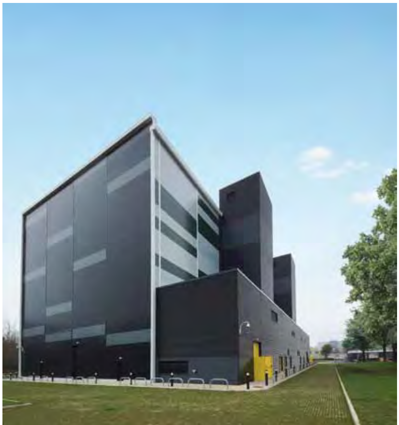
Das Newspaper Storage Building der British Library gehört zum Document Storage Centre in Boston Spa. Dort lagern 664.000 Jahresbände verschiedenster Zeitungen. Es wird von einer „Oxyreduct“ VPSA-Anlage besonders energieeffizient geschützt.
