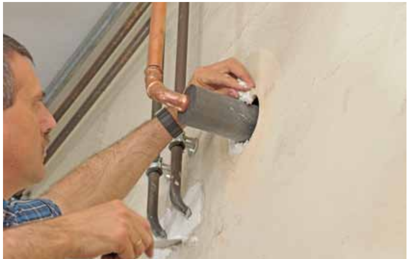
Installation von "Armaflex Protect" von Armacell
