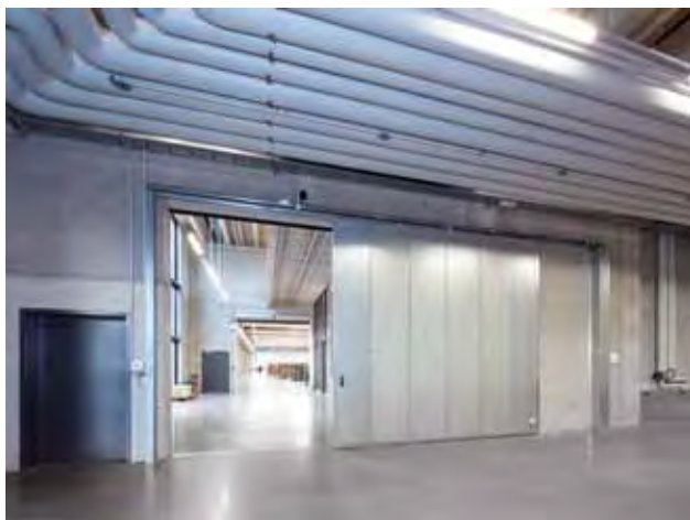
Einflügeliges Novoferm Feuerschutz-Schiebetor mit Feststellanlage und elektrischer Öffnungshilfe als großflächige Brandabschnittstrennung.
