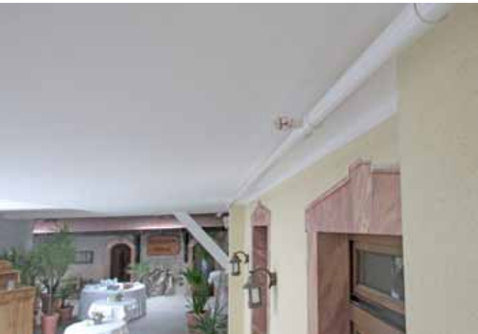
Bild 2: Die Verlegung von Residential-Seitenweirwurf-Sprinklern ist ohne Eingriff in die vorhandene Decke möglich.
