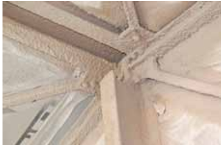
Abb. 3: Mit dem Brandschutz-Gipsputz „MP 75 L Fire“ versehene Stahlträger und -stützen
