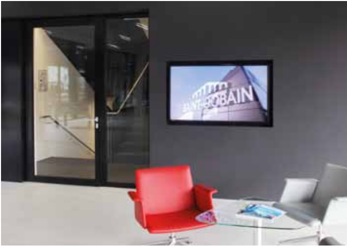
Im Foyer wurden „NovoFire“-Aluminium-Türen mit Seitenteil eingesetzt – die Brandschutzfunktion unterstützt dabei auch das Lärmschutzkonzept des Hauses.
