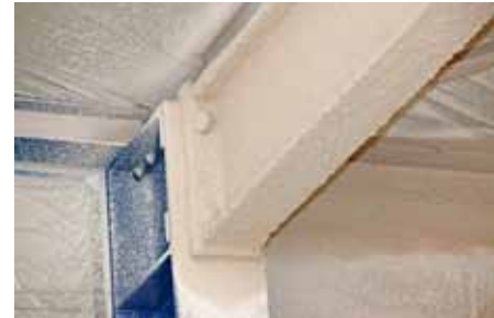
Abb. 4: Brandschutz-Gipsputz im Betonbau
