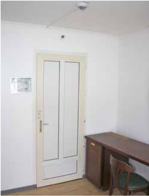
Bild 3: Speziell ausgelegte Residential-Sprinkler gewährleisten Brandschutz in Wohnräumen.
