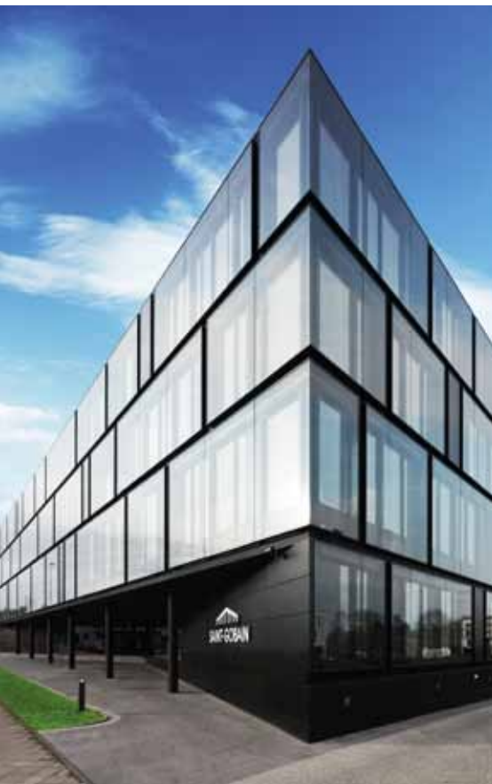
Die neue Generaldirektion Mitteleuropa von Saint-Gobain in Aachen: Die Leichtigkeit der Architektur bestimmte auch das Anforderungsprofil für die Brandschutztüren von Novoferm.
