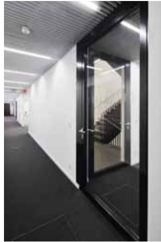
Gänge und Treppenhäuser sind ebenfalls durch Türen des Systems „Novo Fire“ aus Aluminium zu erreichen.
