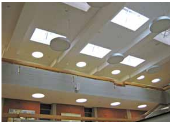
Neben vier „Firefighter“ mit RWA-Funktion wurden acht weitere verbaut, die das Tageslicht durch die Zwischendecke lassen.
