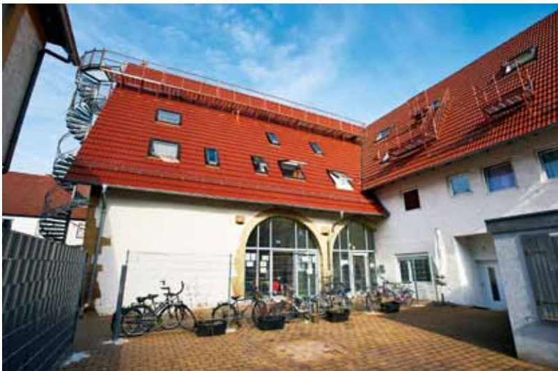
Noch während der Bauphase wurde dieses ursprünglich als Hotel geplante Gebäude in Richtung Flüchtlingsunterkunft weiterentwickelt.
