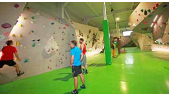
Abb. 5: Blick in die Kletterhalle mit brandgeschützten Mittel- und Randstützen
