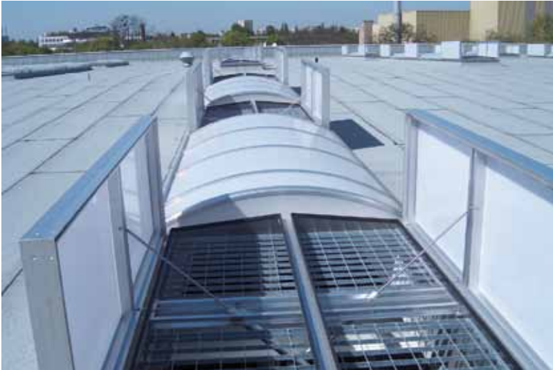
Durchsturzicherungen verhindern, dass Personen bei geöffneten Geräten durch das Dach fallen können.
