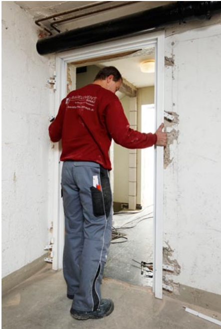
Die Prüfung und Zulassung von Feuerschutzabschlüssen umfasst das gesamte System bestehend aus Zarge, Türelement und Beschlägen. Im Sanierungsfall genügt daher beispielsweise nicht allein der Austausch des Türblatts.
