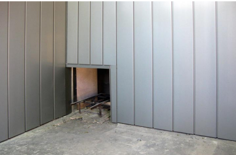
Vorbereitung einer Brandprüfung: Steckfalzpaneele von Rhein-zink auf Metallunterkonstruktion.
