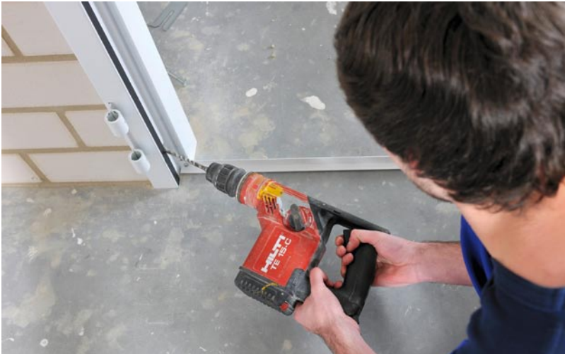
Schräg bohren: Die Zarge wird schräg laufend verschraubt, was die Montage im Vergleich zu anderen Befestigungsarten vereinfacht
