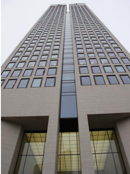
Der Frankfurter Opernturm war Schauplatz eines Praxistests zur dynamischen Fluchtweglenkung
