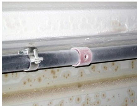
„Ansaugrauchmelder SecuriRAS ASD 535“: Ansaugöffnung mit Clip in der flexibel und asymmetrisch realisierbaren Ansaugleitung.
