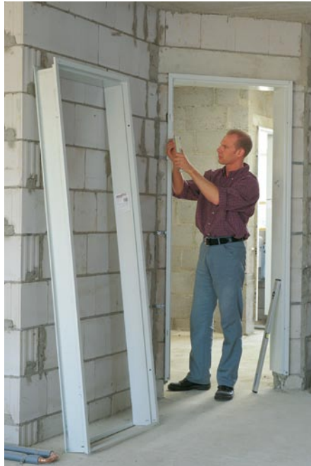
Die „Allgemeine bauaufsichtliche Zulassung“, ausgestellt vom Deutschen Institut für Bautechnik (DIBt), schreibt detailliert vor, für welche Wandkonstruktionen der jeweilige Feuerschutzabschluss genehmigt und wie er einzubauen ist.
