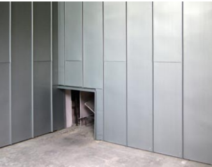
Vorbereitung einer Brandprüfung: Winkelstehfalz von Rheinzink auf Holzschalung.
