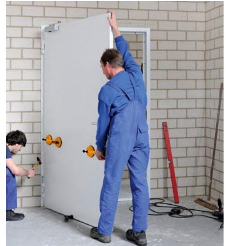
Schritt 4: Verschrauben und Türblatt einsetzen – fertig. Das Sichtmauerwerk bleibt bei der mörtelfreien Montage sauber, die Zarge kann nicht durch Mörtel verkratzt oder beschädigt werden
