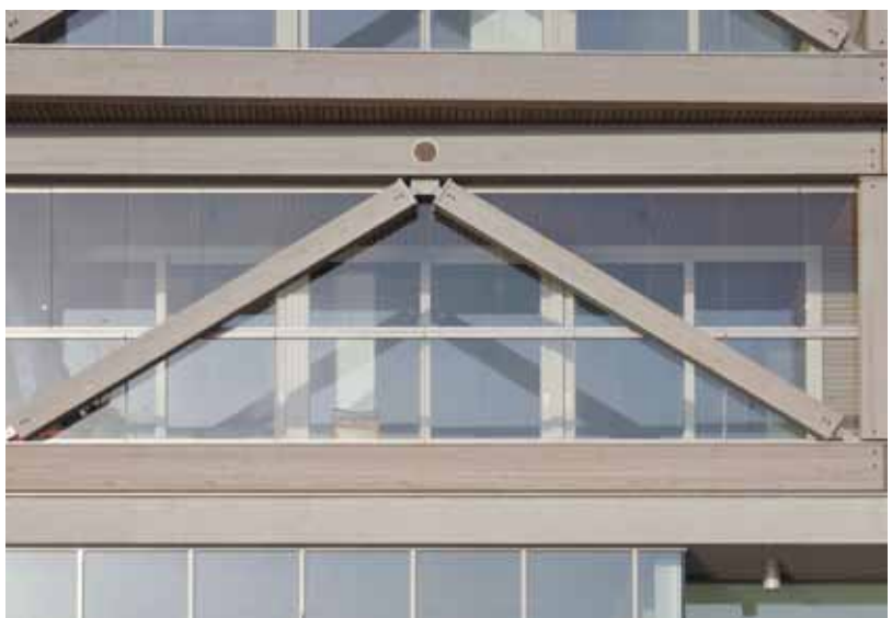
Nahaufnahmen der Gebäudefassade mit den Balkondiagonalen
