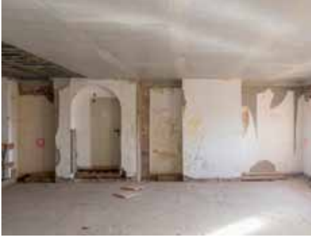
Die über dem Plenarsaal gelegene Büroebene während der Umbauarbeiten.
