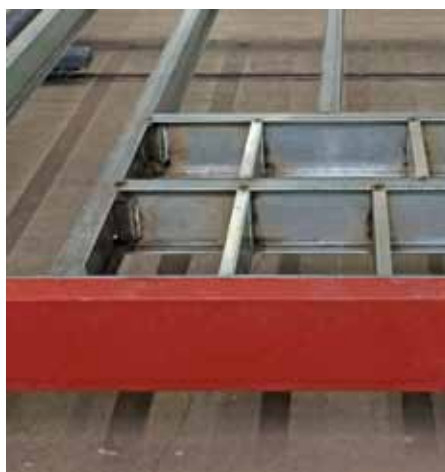
B) Im Stahlbau werden die Profile gemäß Plan eingebaut
