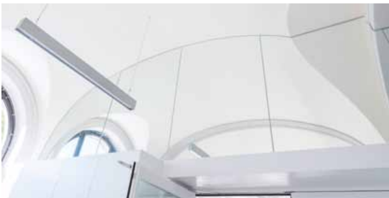
Zu den Herausforderungen des Projektes gehörte es auch, die Glaselemente in der fragilen Decke zu integrieren.
