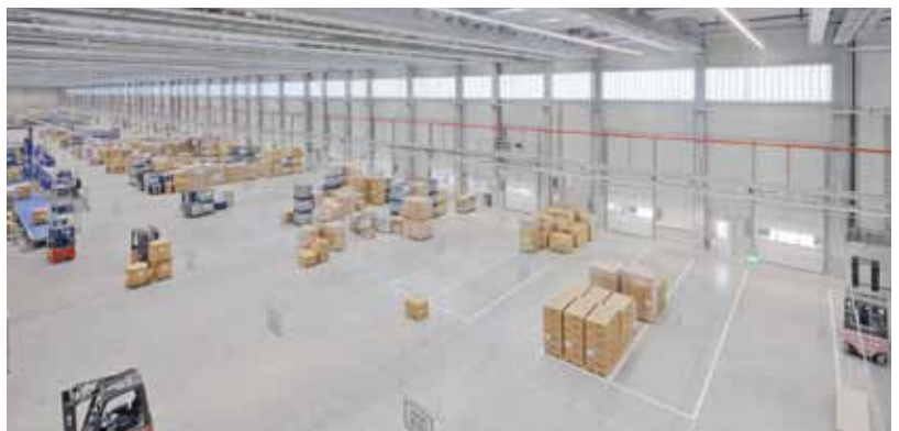
Insgesamt wurden 74 Novoform Industrie-Sektionaltore „Thermo 40“ verbaut. 50 davon schließen innenseitig die Verladeschleusen ab, weitere separieren meist interne Bereiche und weisen häufig Schlupftüren auf.
