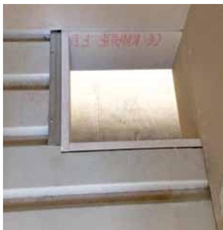
C) Die vorgefertigten Elemente aus Trockenbauplatten schützen die umliegenden Stahlbauprofile
