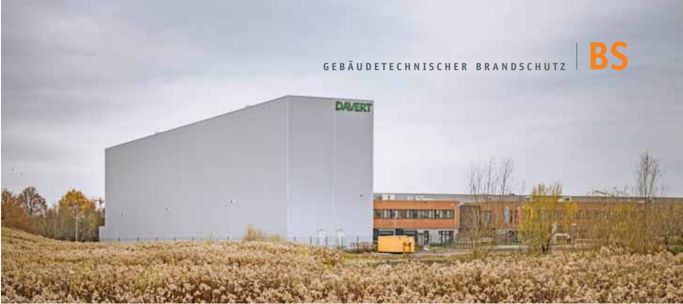
Daverts vollautomatisiertes Hochregallager umfasst ein Volumen von 38.400 m 3 .
