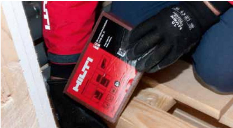
Einfach zu installieren: Der Brandschutzstein "CFS-BL P" zur Abdichtung von Kabeln oder Leerrohren in Wand- und Bodenöffnungen.
