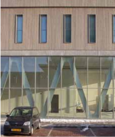
Das Erdgeschoss, wie auch der Gebäudekern bestehen aus Betonfertigteilkonstruktionen. Die Fertigteilkonstruktion erfolgte hier nicht nur aus Brandschutzgründen, sondern auch aus Gewichtsgründen.
