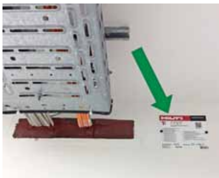
Bei der Ausführung auf der Baustelle, wird das Schottsystem unter Aufsicht der ALHO Bauleitung gemäß Zulassung verbaut. Nach Abschluss der Arbeiten, wird jedes Schott dokumentiert und in einer Brandschutzakte als Teil der Revisionsunterlagen zusammengefasst.
