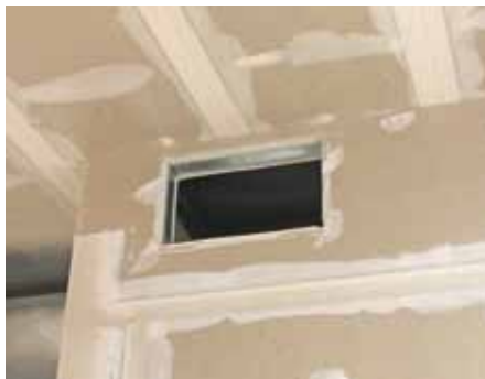
In der Abteilung Wand-Fertigung, werden die bezeichneten Durchbrüche entsprechend der Anforderung produziert und für den späteren Ausbau auf der Baustelle vorbereitet.
