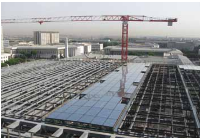
Blick auf das 12.000 m 2 große Glasdach des Kongresszentrums in Rom während der Bauphase.
