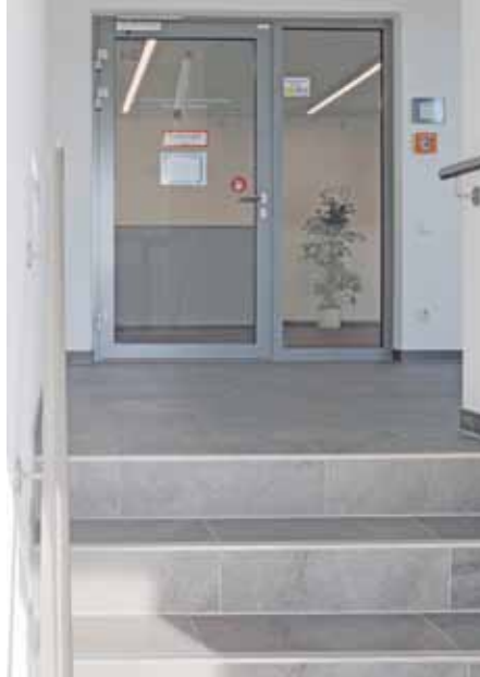
„NovoFire T30-1 RS“ mit Seitenteil in F30, in sehr robuster Ausführung mit drei Türbändern für den Alltagsbetrieb innerhalb des Verwaltungstrakts. Durch die drei verwendeten Türbänder ist die Nachrüstung eines Drehflügelantriebs möglich.
