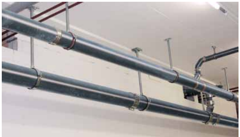
Nichtbrennbares gusseisernes Abflussrohrsystem mit Sonderbeschichtung Typ „MLK-protect“ (Düker)
