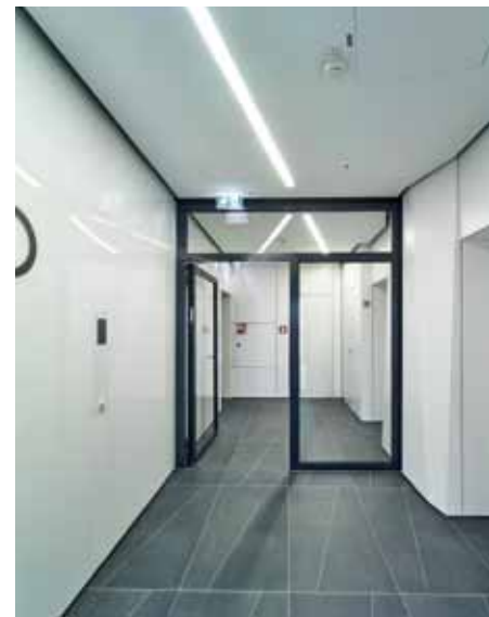
Im gesamten Gebäude schaffen großflächig verglaste Stahl-Rohrrahmenelemente von Hörmann Sichtverbindungen und gewährleisten den baurechtlich geforderten Brand- und Rauchschutz.
