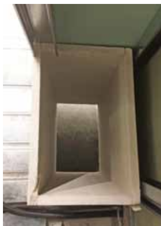
C) Die vorgefertigten Elemente aus Trockenbauplatten schützen die umliegenden Stahlbauprofile
