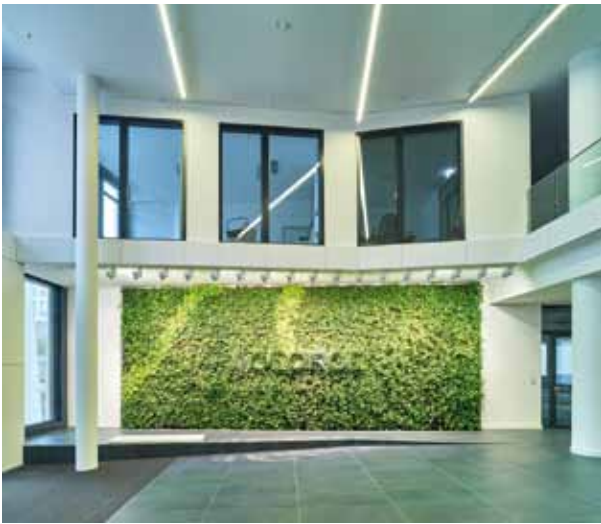
Die raumhohen Hörmann Durchblickfenster wurden als Sonderformat gebaut, dessen doppelte Spezialverglasung Absturzsicherheit nach TRAV gewährleistet und gleichzeitig dem Brand-, Rauch- und Schallschutz gerecht wird.
