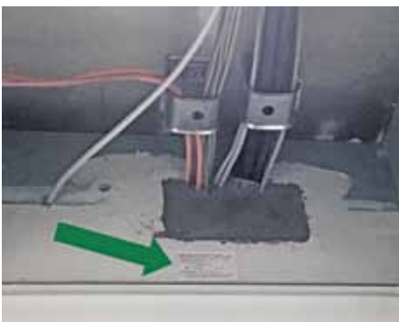
Bei der Ausführung auf der Baustelle, wird das Schottsystem unter Aufsicht der ALHO Bauleitung gemäß Zulassung verbaut. Nach Abschluss der Arbeiten, wird jedes Schott dokumentiert und in einer Brandschutzakte als Teil der Revisionsunterlagen zusammengefasst.
