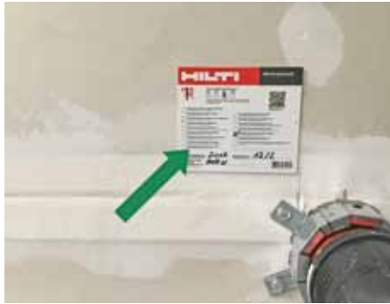
Der ausführende Unternehmer bestätigt nach Abschluss der Arbeiten die fachgerechte Ausführung der Brandschottung.
