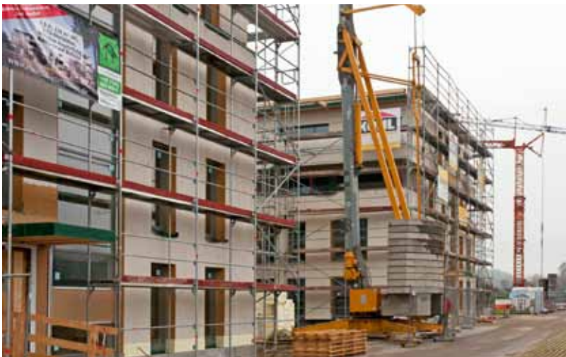
Riedpark/Lauchringen: Zwei viergeschossige Mehrfamilienhäuser komplett in Holzbauweise made of Ligno errichtet.
