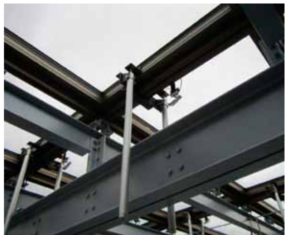
Fertige RWA-Flügel über dem Stahl-Dachtragwerk des Kongresszentrums in Rom.
