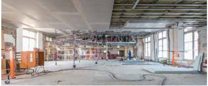
Die Deckenkonstruktion der Büroebene wurde zweilagig mit 2 x 20 mm „Aestuver“ Brandschutzplatten ausgeführt. Die Konstruktion erreicht die Brandschutzklasse F 90.
