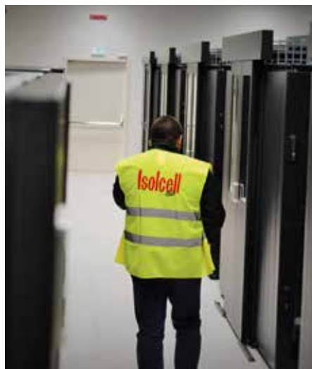
Geschützte Bereiche sind jederzeit begehbar. Die Schutzatmosphäre ist problemlos atembar.
