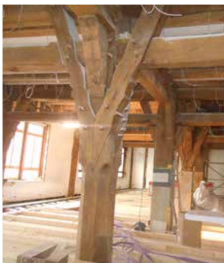
Alte Balkenlagen genauso wie Mauerwerk mit größeren „Maßtoleranzen“ kamen zum Vorschein.
