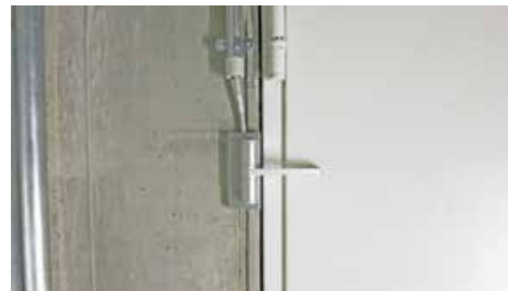
Drehwinkelgeber an der Tür
