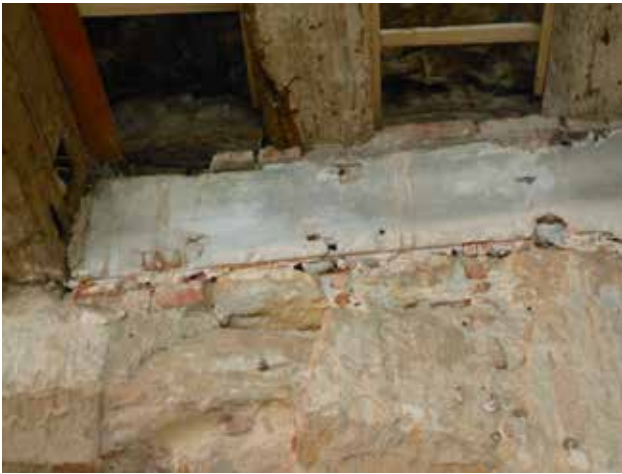
In den öffentlich genutzten Räumen des Erdgeschosses sollte die Holzbalken-Geschossdecke (eingestuft nach Bauart IV) brandschutztechnisch auf F 60 ertüchtigt werden. Der Wandanschluss der Brandschutzdecke an die historischen Balken erfolgte mit einem Streifen aus „Glasroc F“-Brandschutzplatten.
