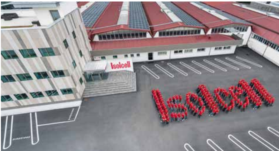
Unternehmenszentrale von Isolcell in Süd-Tirol.
