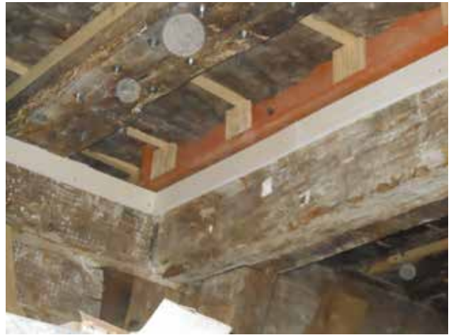
In den öffentlich genutzten Räumen des Erdgeschosses sollte die Holzbalken-Geschossdecke (eingestuft nach Bauart IV) brandschutztechnisch auf F 60 ertüchtigt werden. Der Wandanschluss der Brandschutzdecke an die historischen Balken erfolgte mit einem Streifen aus „Glasroc F“-Brandschutzplatten.
