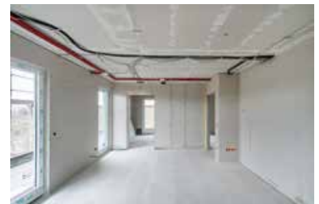
Die Wände erhielten eine ein- bzw. zweilagige Bekleidung aus fermacell Platten.
